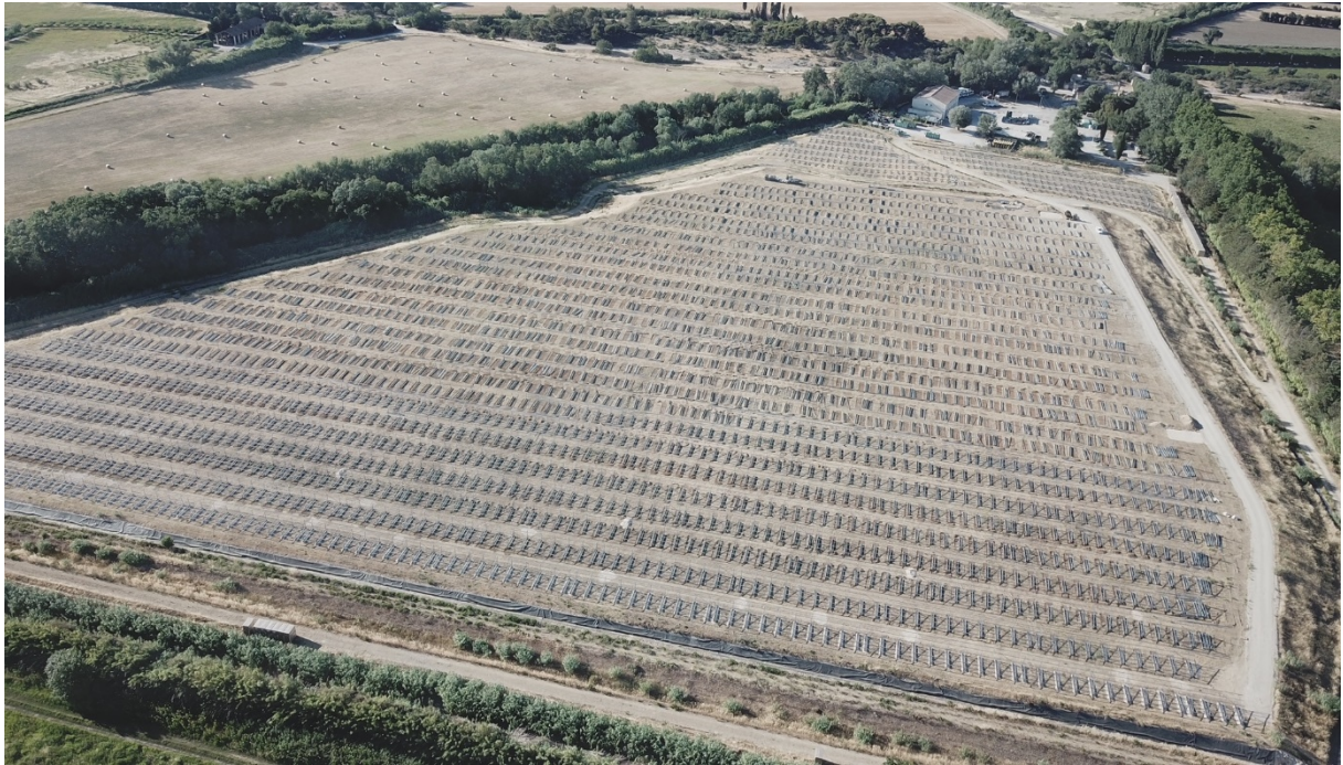
Centrale solaire Vallée des Baux-Alpilles en construction - LUXEL
