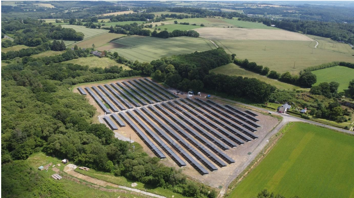
Centrale solaire de Saint-Mayeux (crédit photo Bouygues)
